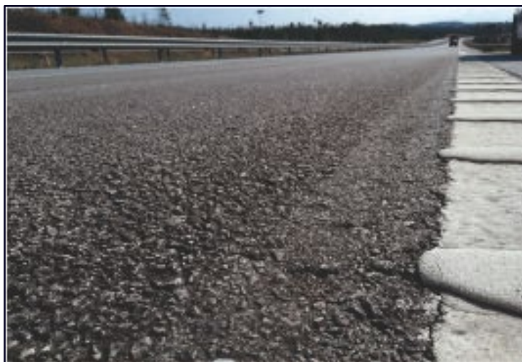
Detalle de firme en su capa de rodadura
