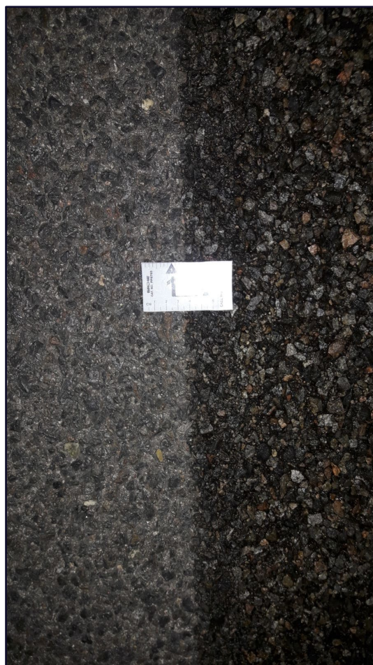
Detalle del firme antes/después
