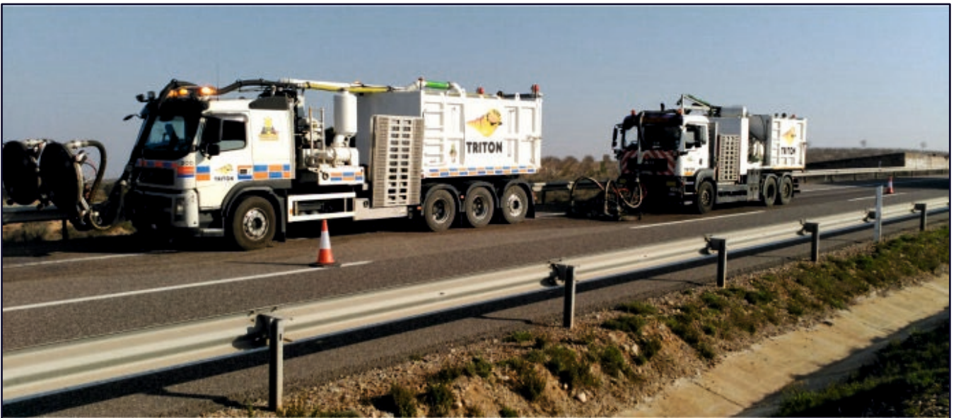
Maquinas de hidrodesebaste de firme con sistema “Stripe Hog”
