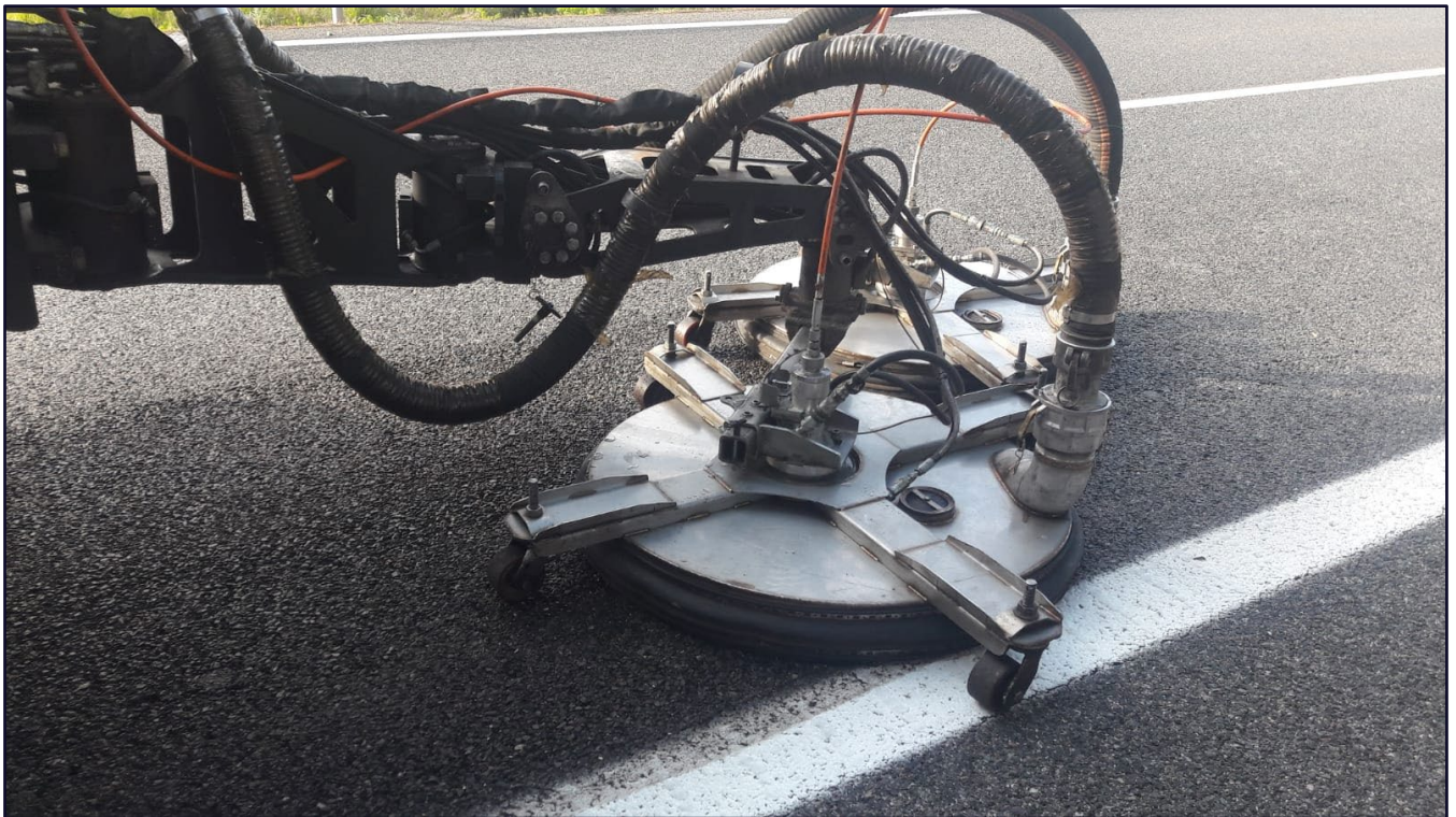
Maquinaria de hidrodesebaste en plena operación
